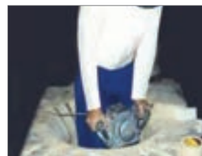
شکل ۱۳- کوبیدن نسوز کف کوره با کوبه ماشینی
